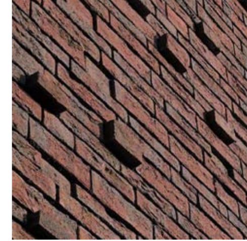
opvallende textuur met verspringende bakstenen
